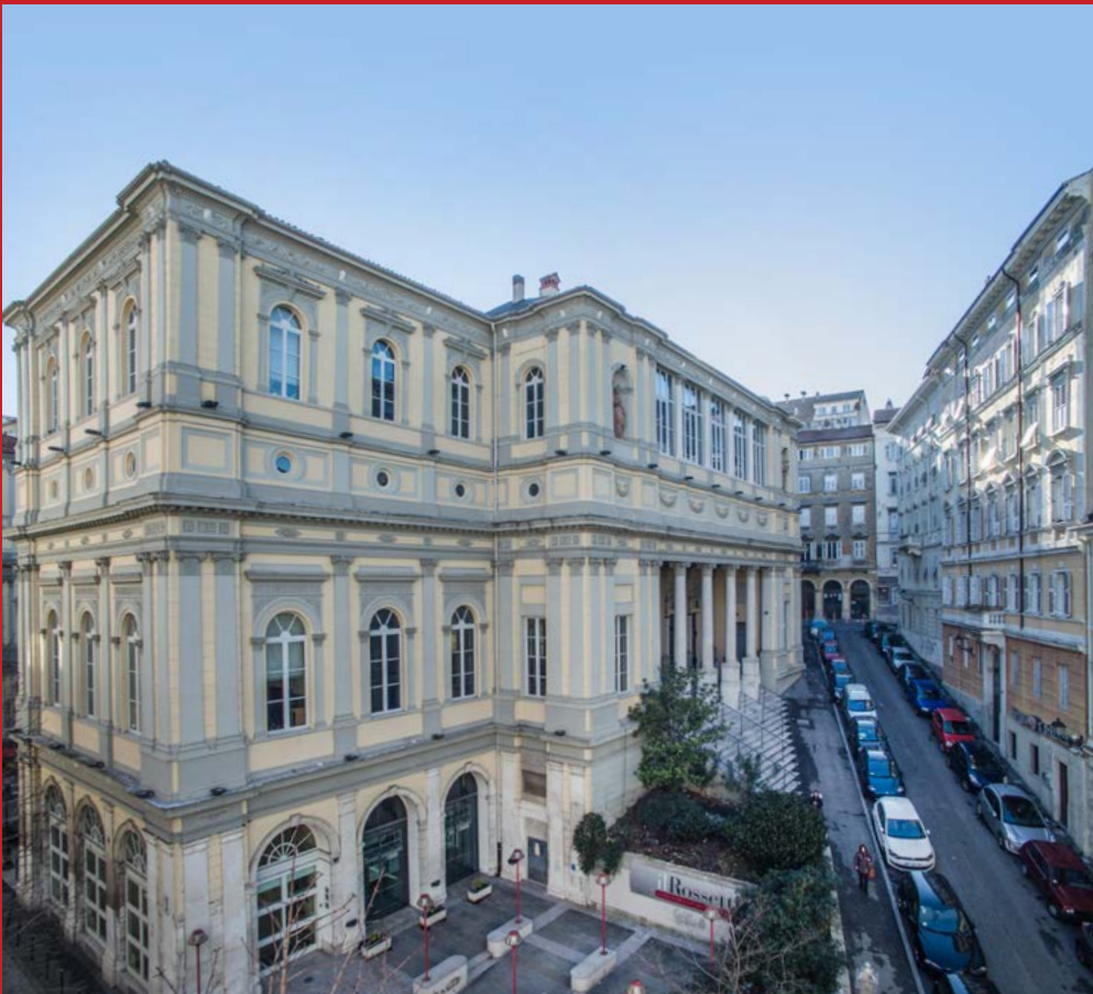
INTERNO ED ESTERNO DEL POLITEAMA ROSSETTI. LA SALA PRINCIPALE, GRAZIE AL CONTRIBUTO DELLA FONDAZIONE, È STATA DOTATA DI UN MODERNISSIMO IMPIANTO AUDIO, CHE SOSTITUISCE QUELLO DATATO 2003
